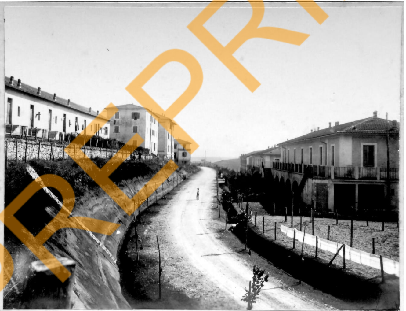
1: Case a ballatoio per operai, case 5-6-7-8, fotografia d'epoca, Colleferro. Archivio multimediale "Città morandiana", estratto dalla tesi di laurea di Bianca Coggi.
