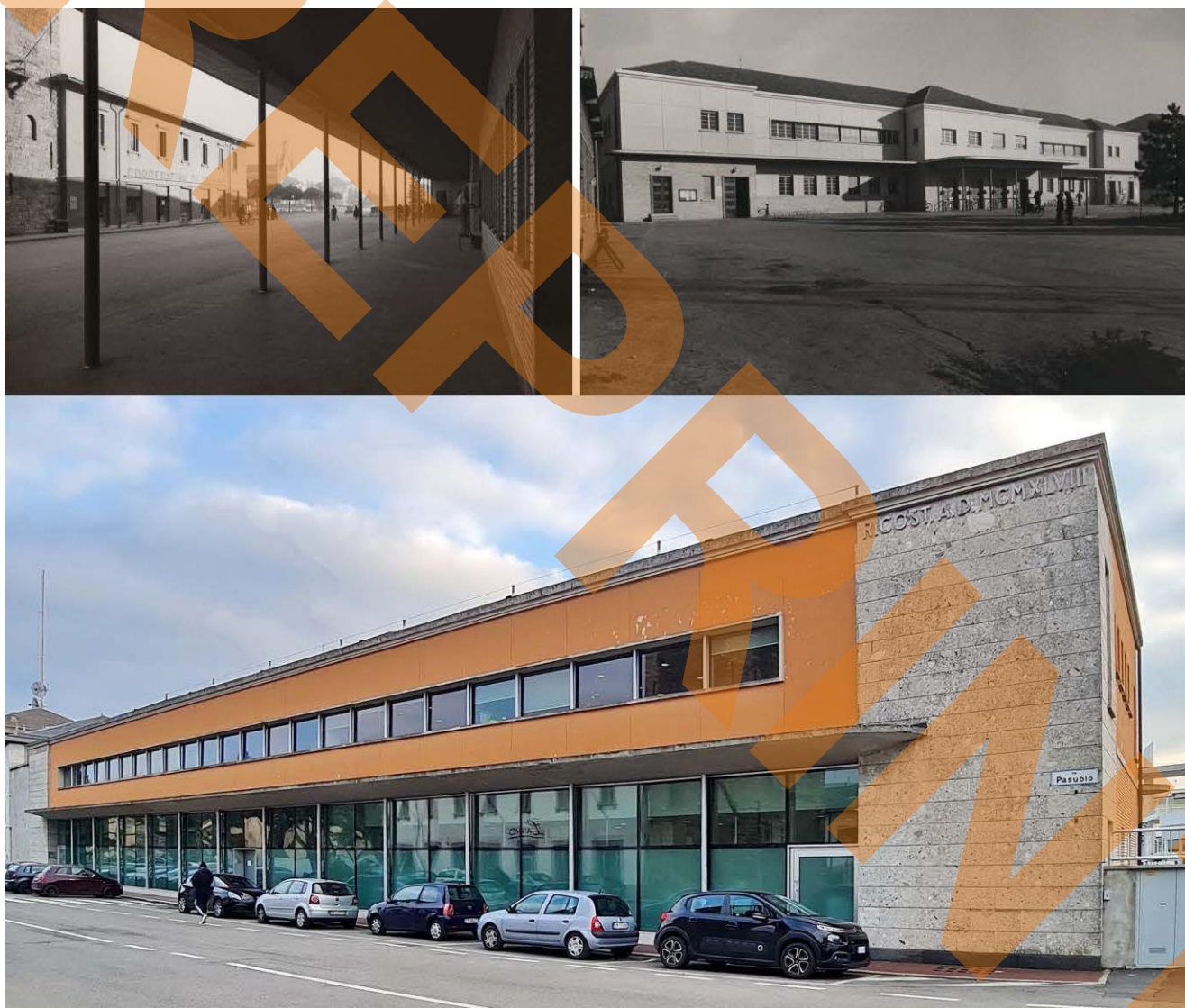
7: La nuova portineria operai, su viale Pasubio: sopra in due foto degli anni Cinquanta (©Fondazione Dalmine) del portico verso strada e del fronte sud; in basso, nello stato attuale (foto G. Mirabella Roberti).
