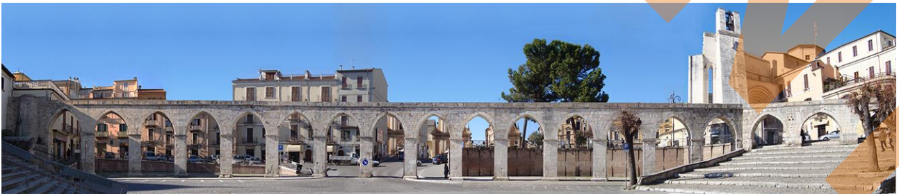
6: Roberta Del Signore, Sulmona, acquedotto svevo, veduta attuale da piazza Garibaldi.
