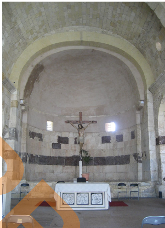
3: Cagliari, Basilica di San Saturnino oggi, interno, particolare dell'arco absidale in tufo e di parte della volta a botte della navata centrale (foto Nicoletta Usai).
