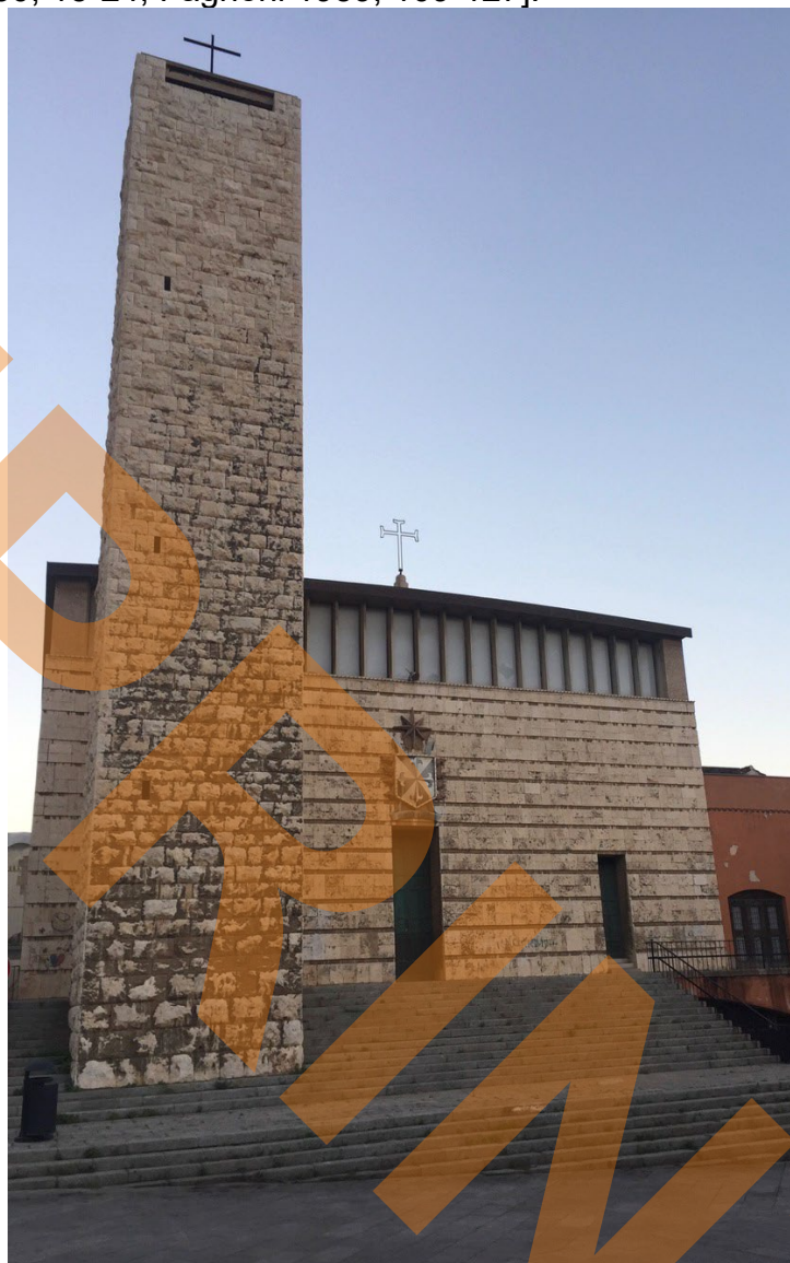
6: Cagliari, Chiesa di San Domenico, foto della facciata e del campanile dell'edificio costruito dall'architetto Raffaele Fagnoni tra il 1952 e il 1954 (foto Claudio Nonne).
