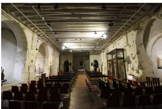
5: Cagliari, Cripta di San Domenico, foto dell'interno, che ingloba parte delle preesistenze. Sono evidenti le coperture in cemento armato che sostengono la chiesa soprastante, costruita dall'architetto Raffaele Fagnoni tra il 1952 e il 1954 (foto Claudio Nonne).
