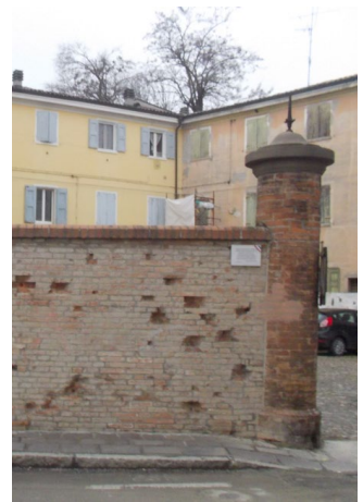
1c: I tasselli di integrazione sulle facciate degli edifici di Reims.
