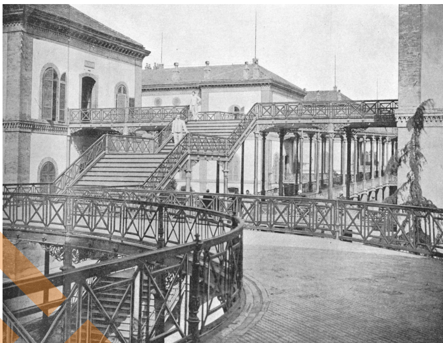
6: Roma, Ospedale Militare Celio, particolari della galleria centrale (Traniello 1901).
