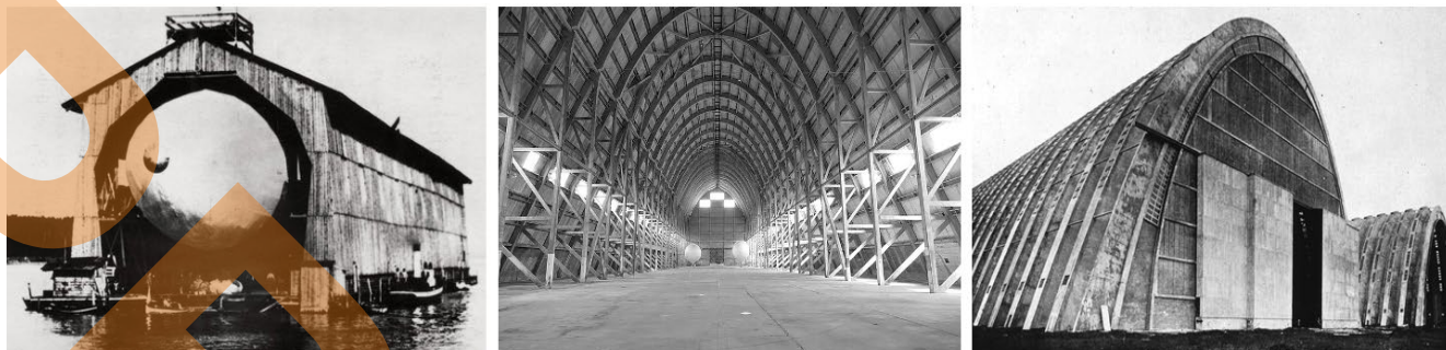
2: Hangar di Ecausseville – Montebourg (Germania) 1899; Hangar di Ecausseville – Montebourg (Francia) 1916; Hangar di Orly (Francia) 1921.
