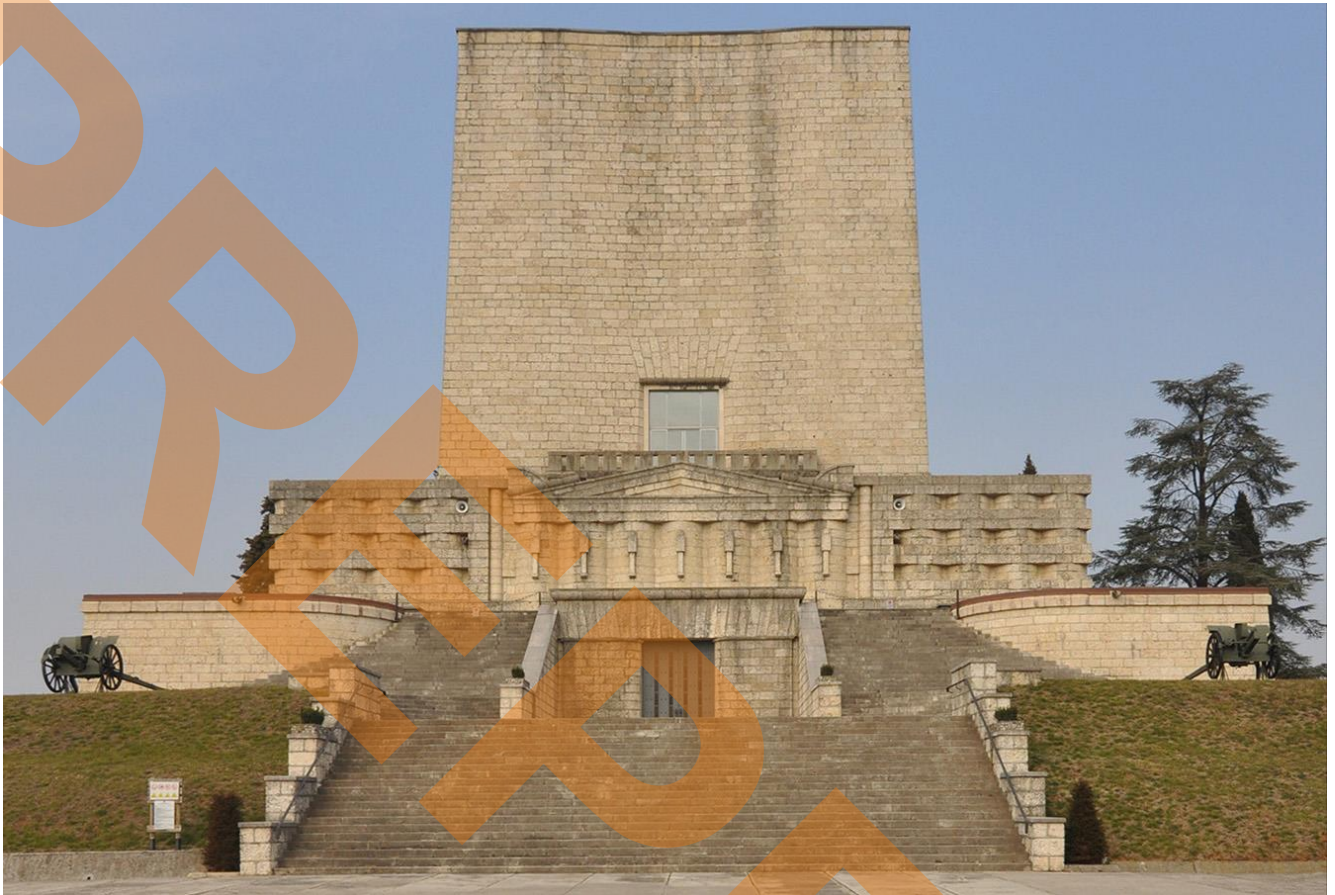
1: Prospetto principale del Sacrario del Montello, con il suo aspetto di massiccio fortilizio turrato. La scalinata principale consente di raggiungere il portale di accesso; le due ulteriori scalinate laterali conducono invece al primo terrazzamento esterno.
