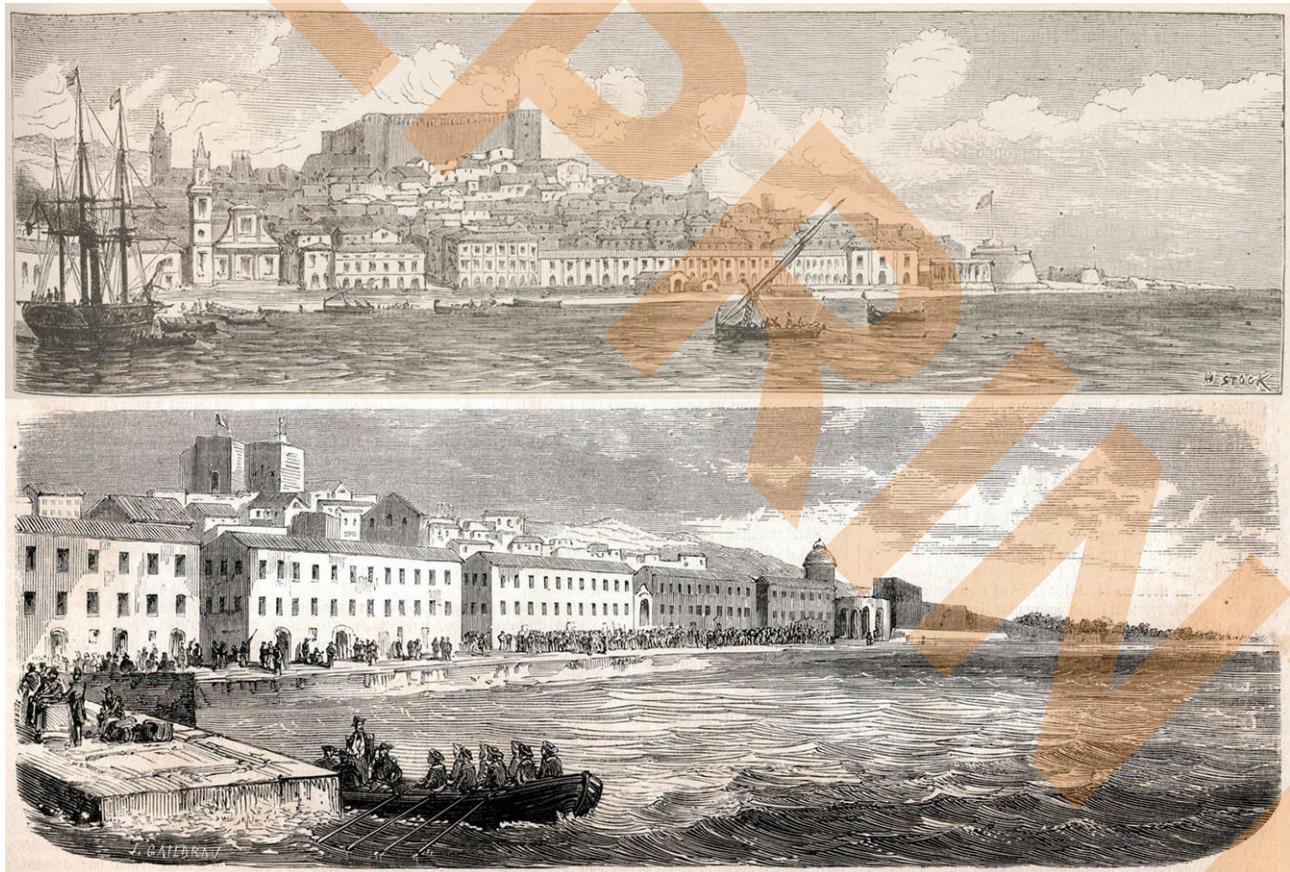
3: Viste sul fronte a mare di Reggio Calabria: confronto. In alto (a): Durand Brager, Vue générale de Reggio , croquis tratto da Le Monde Illustré , n. 178 - 8 settembre 1860, p. 165. In basso (b): J. Gaidrau, La garnison napolitaine attendant son embarquement sur le quai de Reggio , croquis tratto da L'illustration, journal universel , n. 915 - 8 settembre 1860, p. 157.
