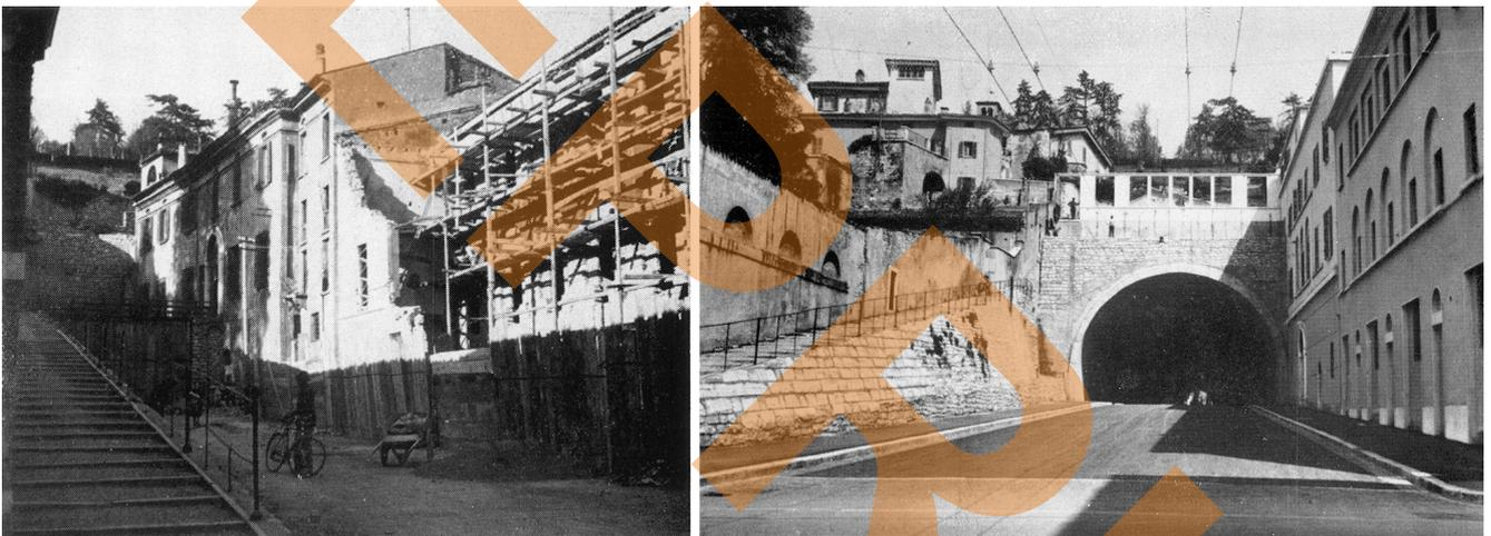
4: Imbocco sud della nuova galleria sotto il colle Cidneo. A sinistra: i fabbricati demoliti per la formazione dell'imbocco. A destra: veduta dell'imbocco a lavori ultimati (Fonte: *La galleria del castello in Brescia (1943-1951)* 1951, 37-38)
