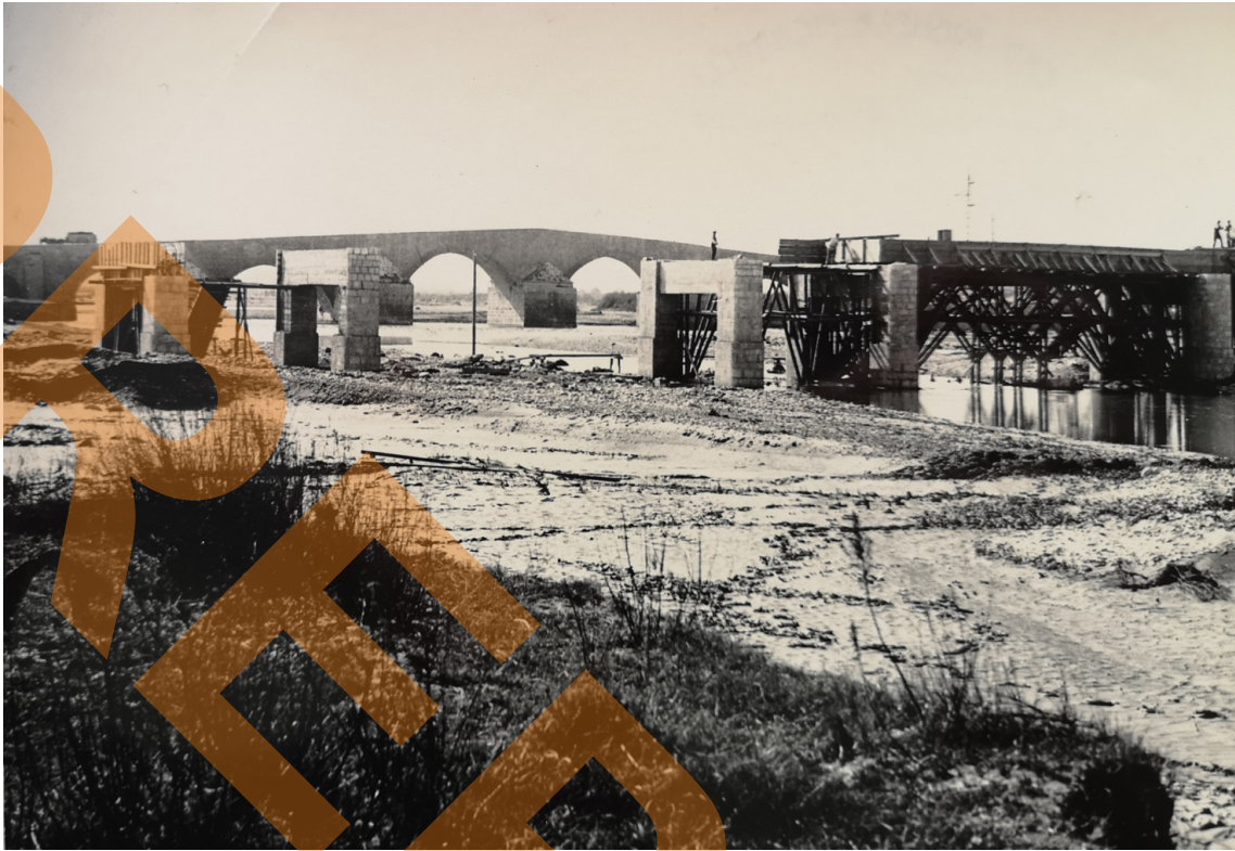
4: Ponte dell'Impero in costruzione vicino a quello più antico, vista da Nord. Foto scattata tra il 1935 e il 1943. (Archivio Pasquale Ieva).
