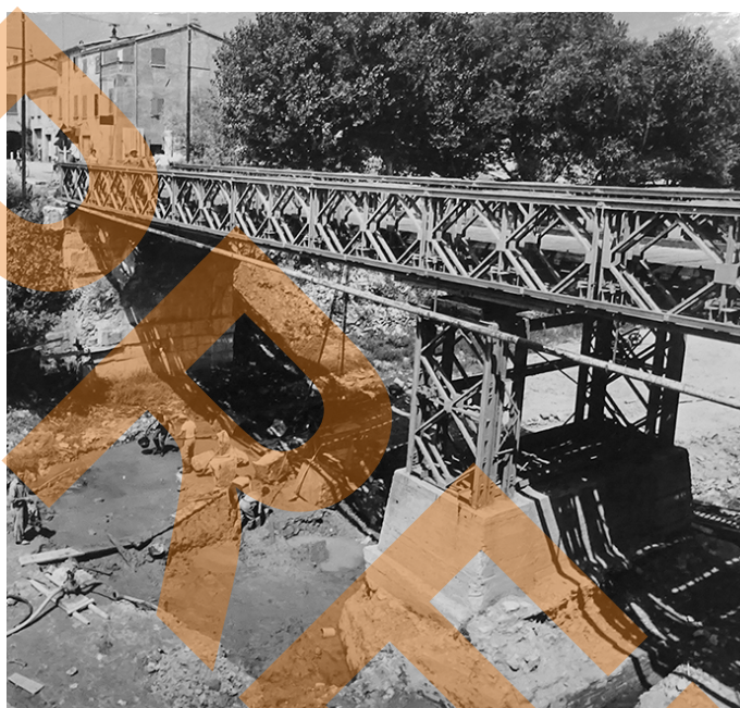
2: Il ponte Bailey e la pila in calcestruzzo gettata sui resti del primo pilone; rilievi dei primi conci recuperati ad opera del Genio Civile (Foto s.a. ASR_GC, B 493, Fasc. 81).
