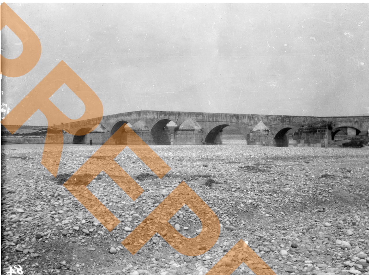
2: Canosa, ponte romano sull'Ofanto, 1913. Foto di Robert Gardner (BSR Archive, Gardner Collection, rg0084).
