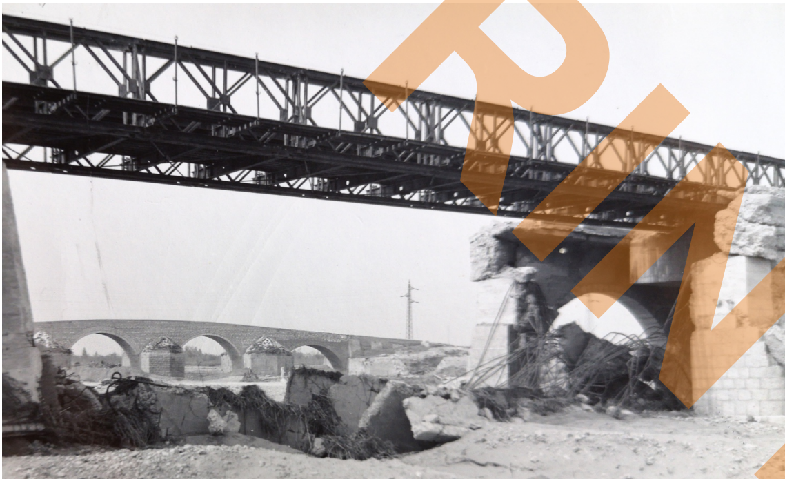
5: Il ponte dell'Impero distrutto sormontato da un ponte Bailey; sullo sfondo, il ponte più antico, ricostruito. 1944. Autore ignoto. [scritto a mano sul retro: Bridge, American plus remains of Germans retrating. Italy 5/44] (Archivio Pasquale Ieva).
