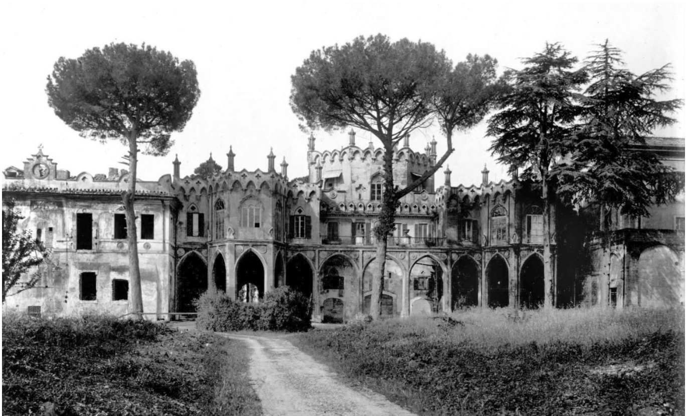
Fig. 4. Villa Mills, demolita per consentire gli scavi archeologici del Palatino.
