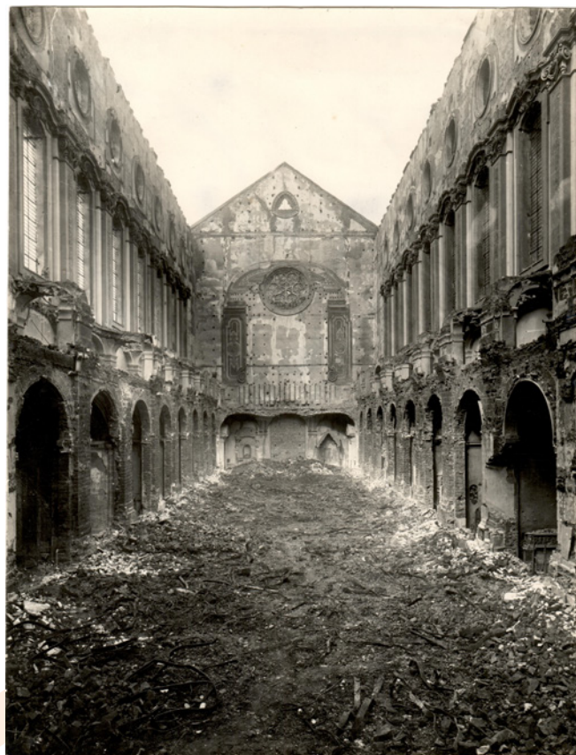
Fig. 14. Devastazione della Chiesa di Santa Chiara , 4 agosto 1943, Napoli Archivio Lembo
