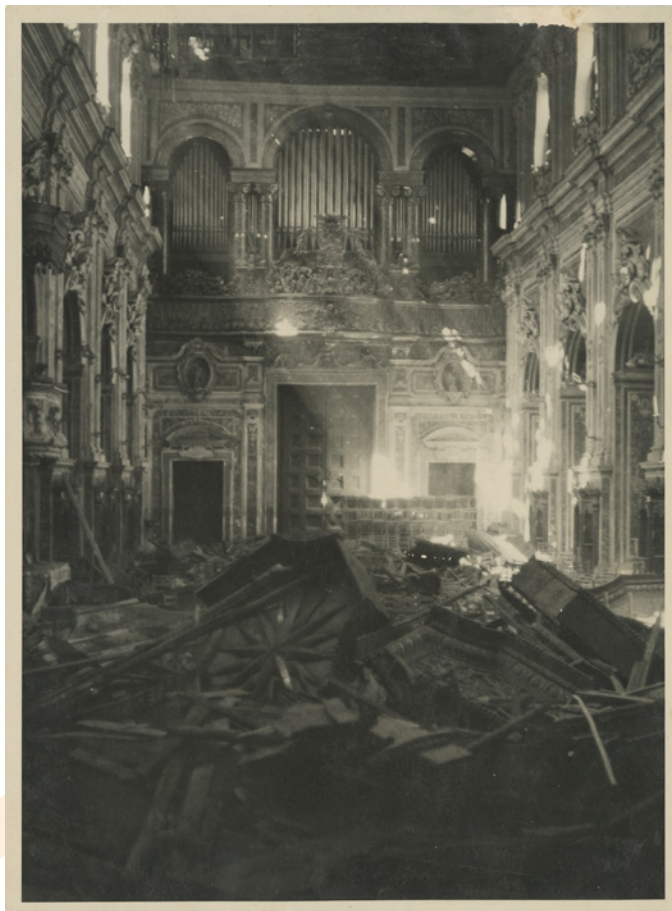
Fig. 8. Studio fotografico Antonio Beuf, Crollo del soffitto della chiesa del Carmine il 28 marzo 1943, Napoli, Archivio Lembo
