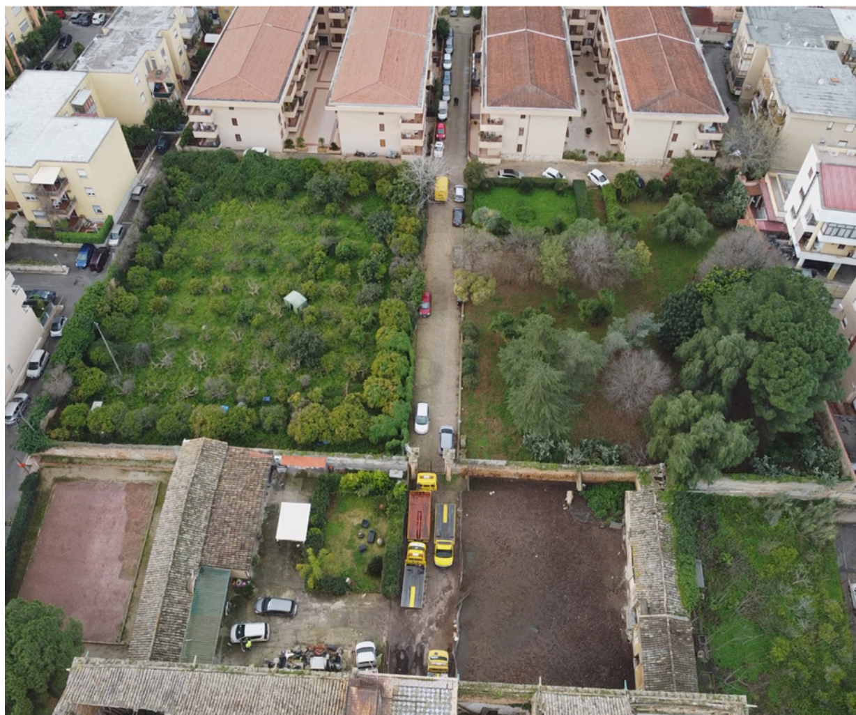
Fig. 1. Villa Arena a Palermo, veduta verso la fabbrica e verso il giardino, in cui si evidenzia il crollo delle coperture e la presenza dell'edificio condominiale sul retro (ripresa A. Bommarito, 2026).
