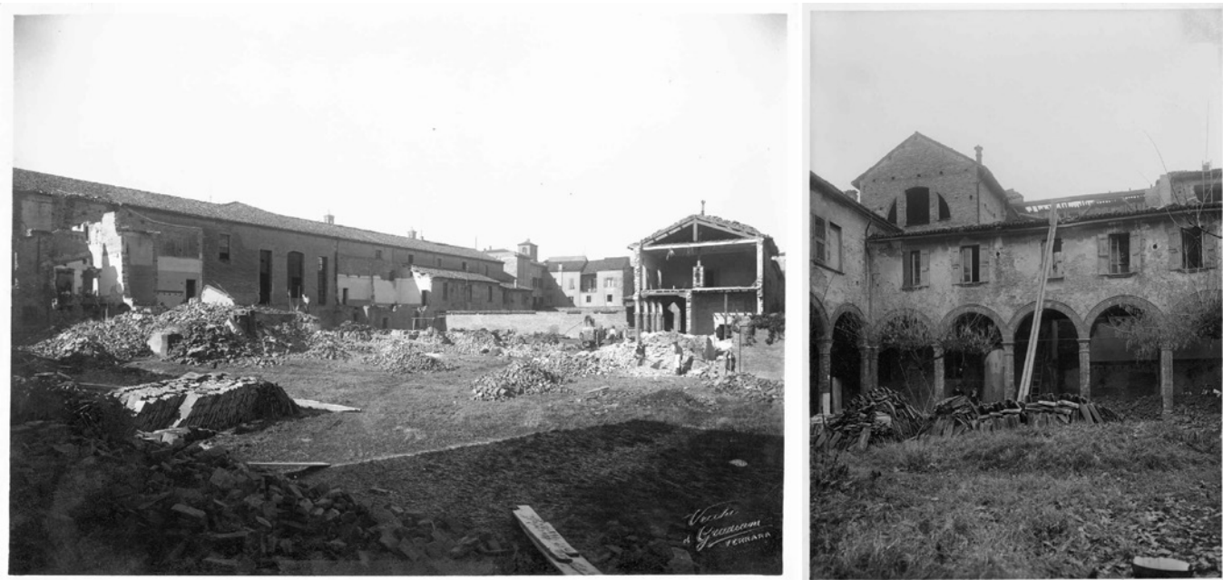
Fig. 2. Ex-Ospedale Sant'Anna durante le demolizioni (1932). A destra vista del chiostro prima dei lavori, FACS racc. 4, foto 101, 106.
