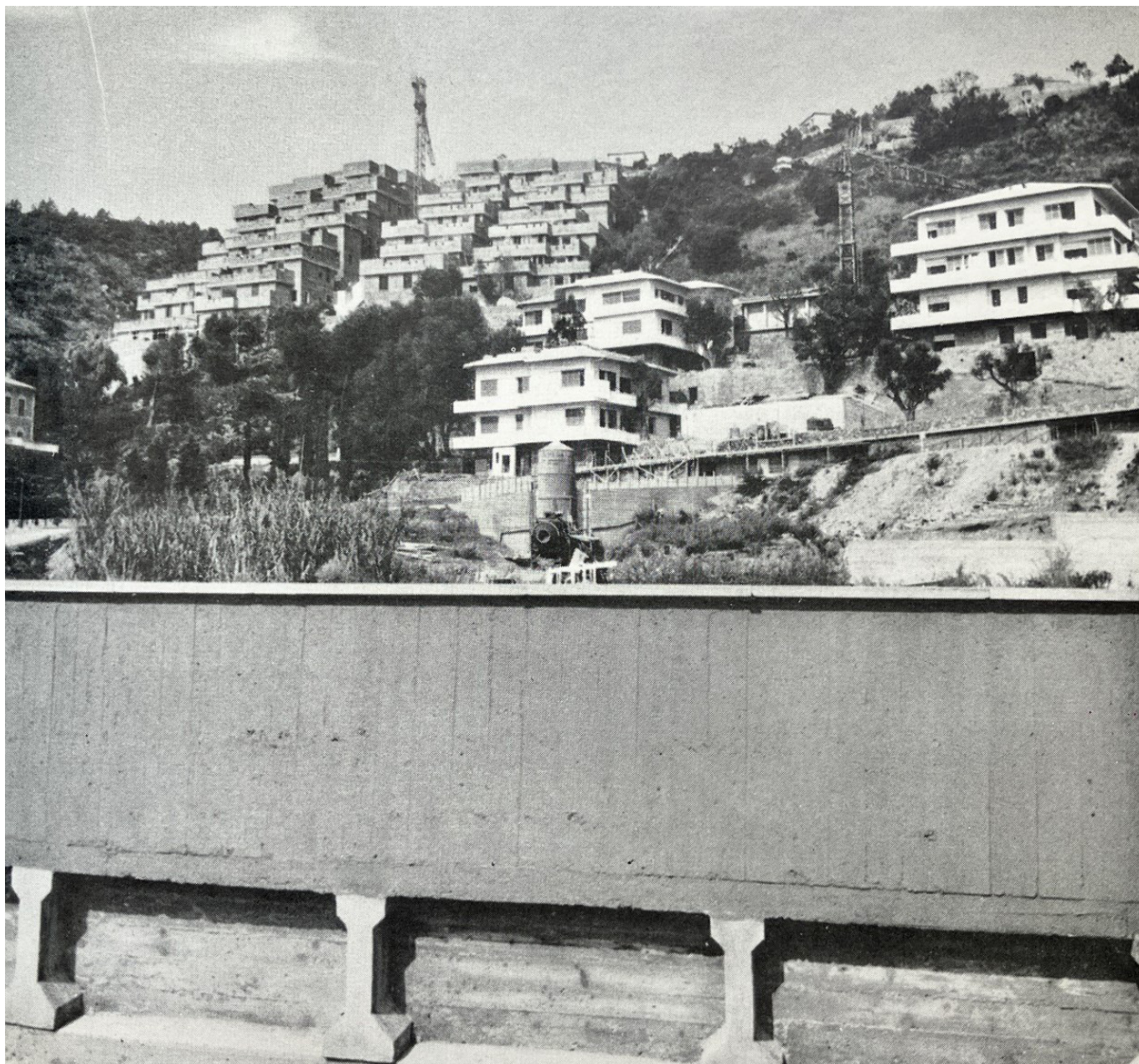
Fig. 1 Il nuovo quartiere residenziale di Arenzano deturpa la costa, Valsecchi 1964, p. 1481.
