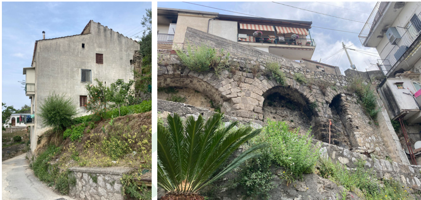
Figg. 4-5. Lavinia Tozzi, Area dell'ex mulino di via Serbatoio, Gragnano: edificio residenziale sorto in sostituzione del manufatto molitorio e resti dell'acquedotto storico adiacente.
