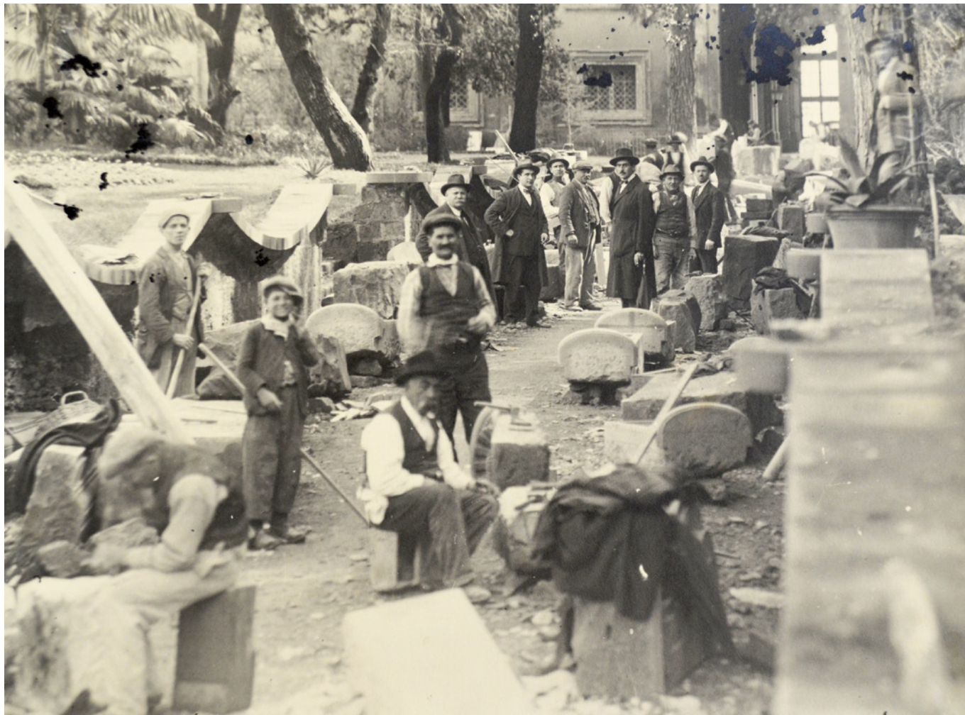
Fig. 1. Scalpellini al lavoro nel cantiere dei giardini di Palazzo Reale a Napoli, Album IV, 1923-1924, Archivio Guerra.
