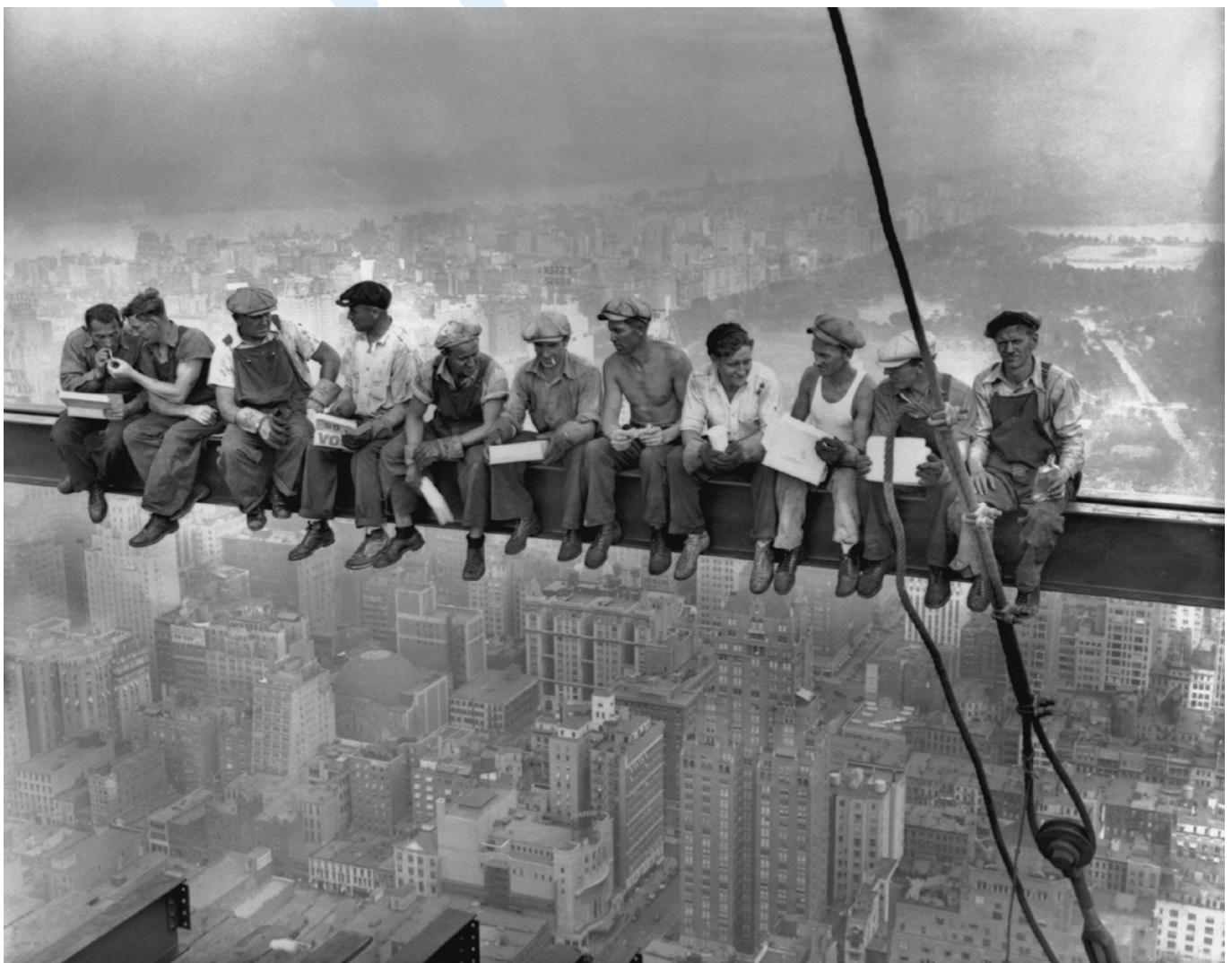
Fig. 1. Lunch atop a skyscraper , Fotografia del cantiere del Rockefeller Center a scopo pubblicitario, 1932.
