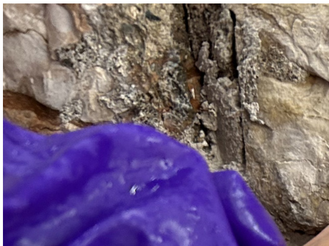
Fig. 3: Trento, Mura di Piazza Fiera, campione di malta 19D (muro nord, settore A, campata D1-D2) sottoposto a caratterizzazione, EffeEffe Restauri s.r.l.
