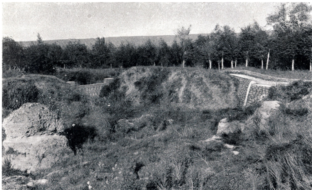
Fig. 1. Una delle dodici vasche di chiarificazione della piana di Quarto. A sinistra si nota il rudere di età romana e in fondo il muro di sbarramento forato che funge da filtro, in BERTARELLI (1922), p. 123.
