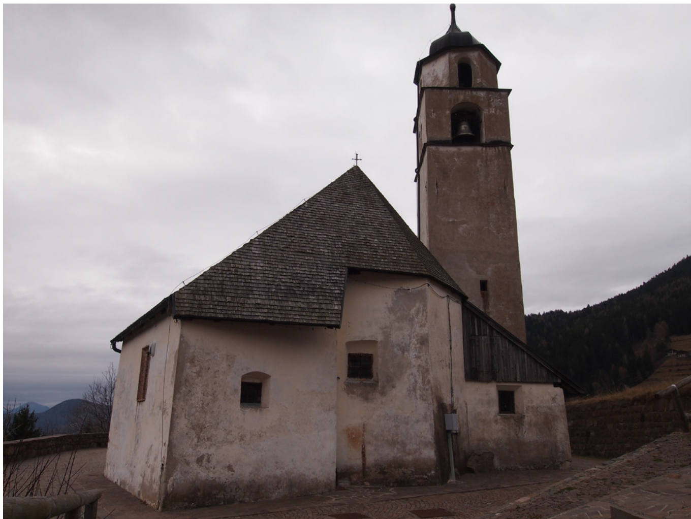
Fig. 1: Palù del Fersina (TN). Vista est della chiesa di Santa Maria Maddalena e San Nicola di Bari prima dei lavori, Giorgia Gentilini.
