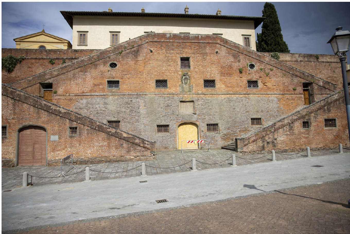
Fig. 3. La visione d'insieme dello scalone monumentale mette in risalto l'organizzazione architettonica per raggiungere il belvedere da cui emerge la sagoma della villa. Gli organismi biodeteriogeni colonizzano estensivamente sia le superfici verticali in laterizio che il rivestimento calpestabile in arenaria.
