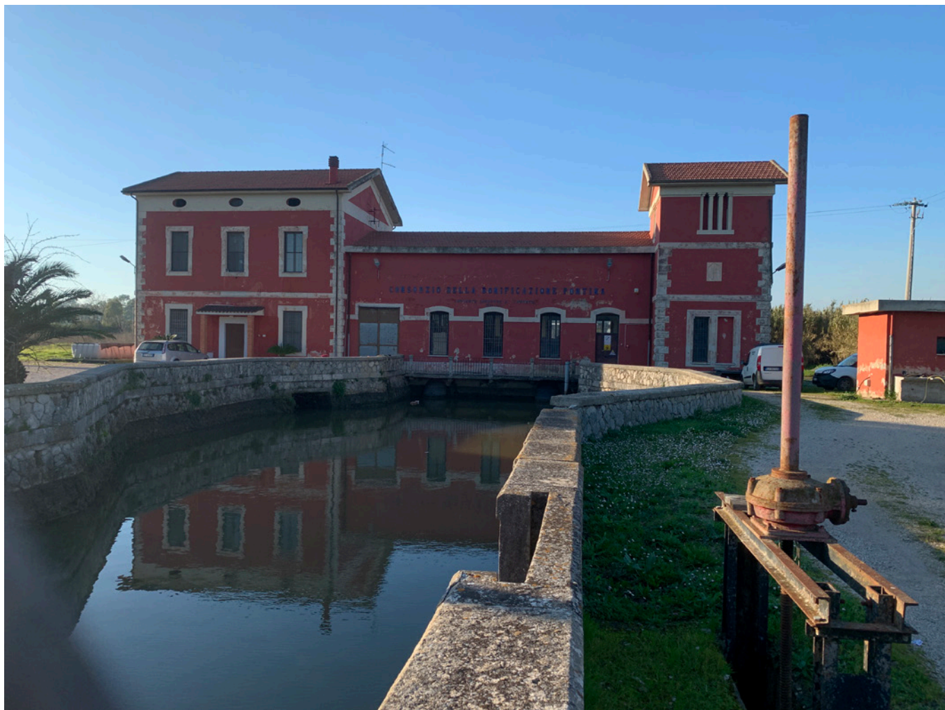
Fig. 2 Alessandro Mattioli, Vista sul prospetto principale dell'impianto idrovoro di Caronte. Proprietà dell'autore.
