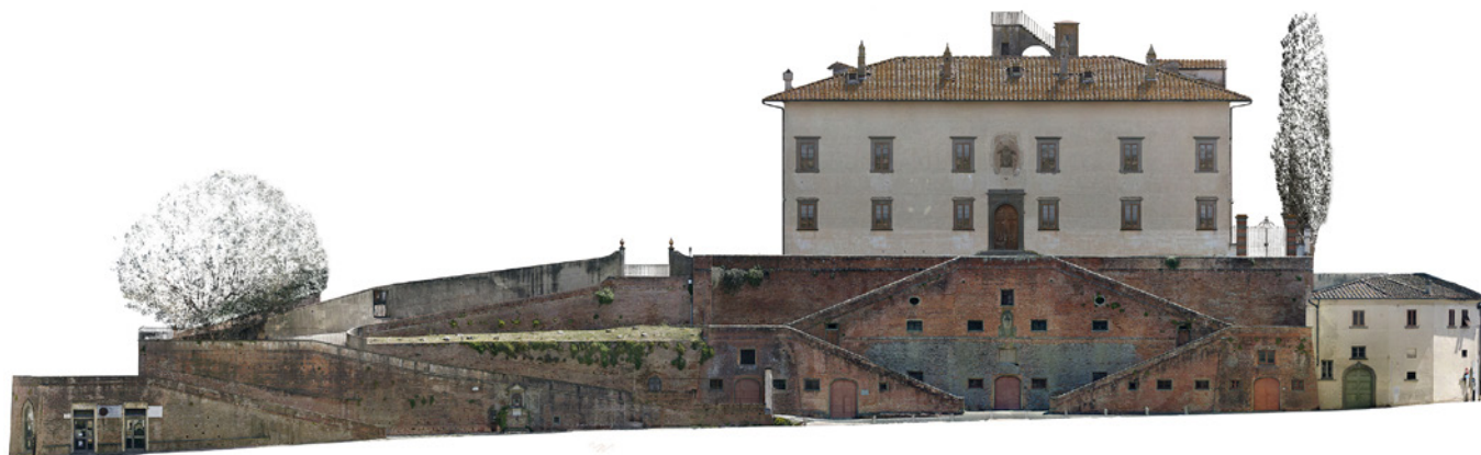
Fig. 1. Cerreto Guidi, Firenze. L'ortofoto del prospetto ovest su Via della Libertà della Villa Medicea mostra in posizione centrale lo scalone monumentale, fortemente interessato da fenomeni di degrado biologico.
