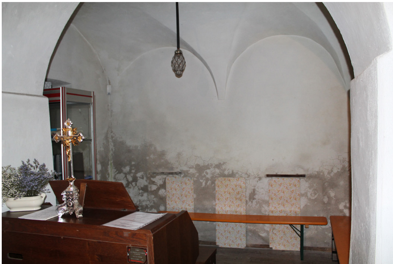
Fig. 2: Palù del Fersina. Vista della parete verso nord della cantoria, prima dell'intervento, Giorgia Gentilini.
