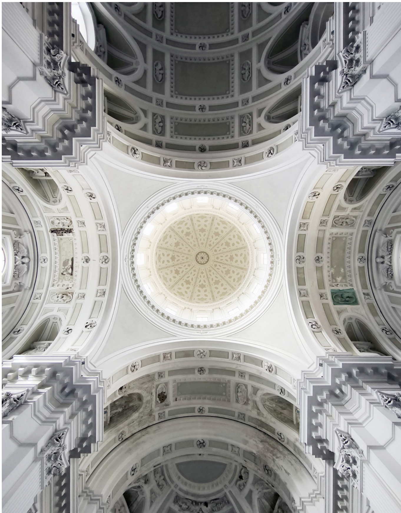
FIG. 5. Napoli, Basilica dello Spirito Santo. Vista dell'intradosso della cupola sulla crociera e della volta a copertura della navata, foto di Antonio Festa 2024.
