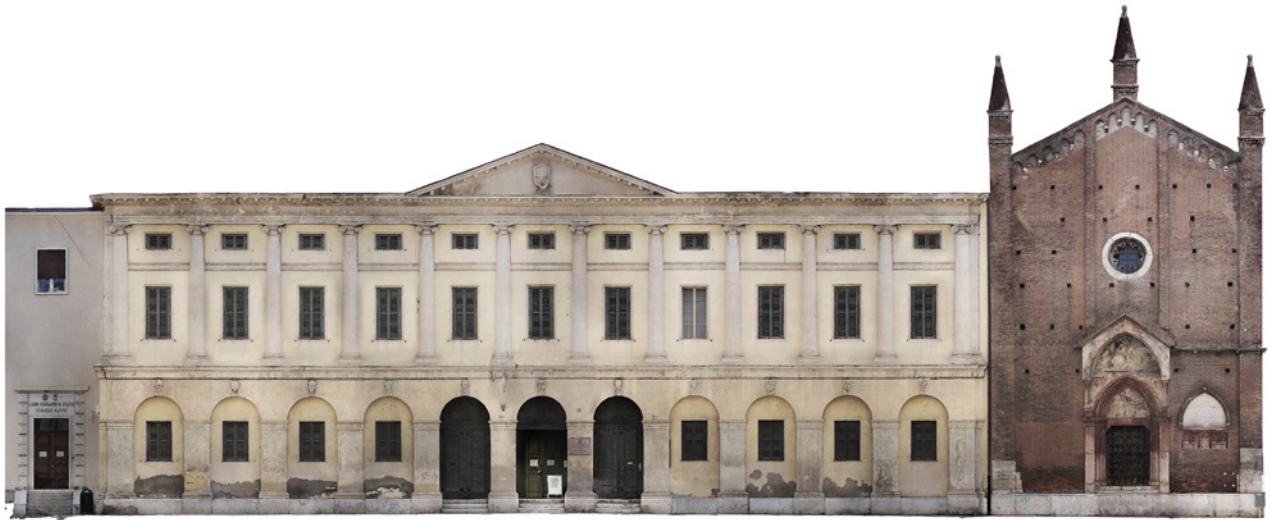
Fig. 4: Università Iuav di Venezia, Complesso di Santa Anastasia, fronte ovest. A sinistra facciata del Conservatorio di musica "E. F. Dall'Abaco", a destra facciata della chiesa di San Pietro Martire.
