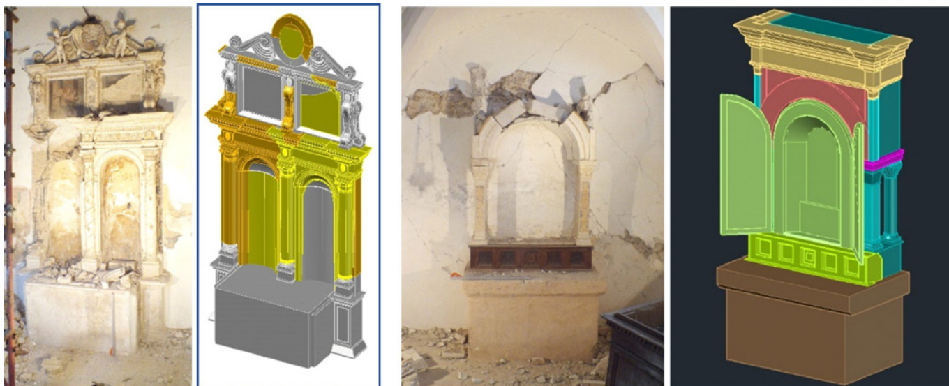
Fig. 5. Ancarani di Norcia. Chiesa della Madonna Bianca. L'uso delle tecniche digitali per valutare l'entità del danno e per supportare il progetto di reintegrazione riferiti agli altari di S. Rocco e della Madonna Bianca.
