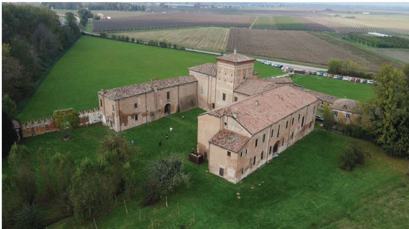
Fig. 1. Vista dall'alto di Villa Mensa a Sabbioncello San Vittore, Copparo, Ferrara.
