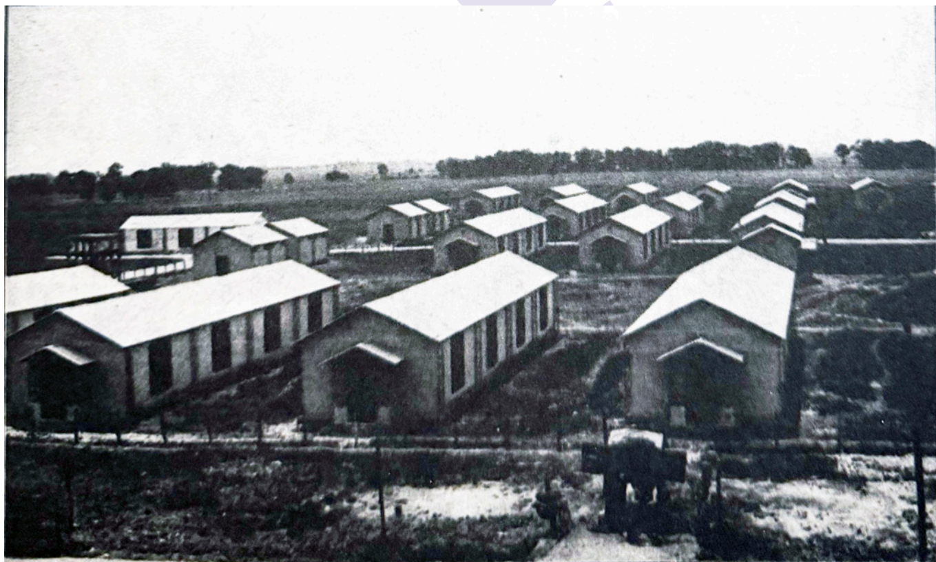
Fig. 3_ Alloggiamenti degli operai a Borgo Podgora (da RIVA 1983, p. 31).
