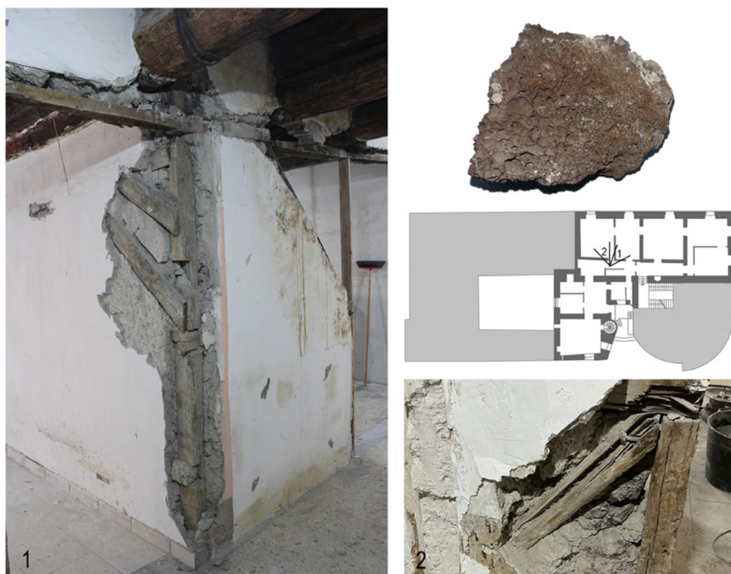
FIG. 5. Napoli, Palazzo Casacalenda, appartamento al livello del secondo ammezzato (ingresso da via Mezzocannone). A sinistra: configurazione d'angolo con ossatura in legno e tamponamento. A destra: dettaglio del vano porta, con evidenza del riempimento in pomici e scorie, della chiodatura, dell'eterogeneità dimensionale delle membrature e della stratigrafia di finitura – rinzafo e intonaco, con tracce di strato finale decorato. In alto a destra: esemplare di scoria lavica proveniente dalle pareti intelaiate rilevate.
