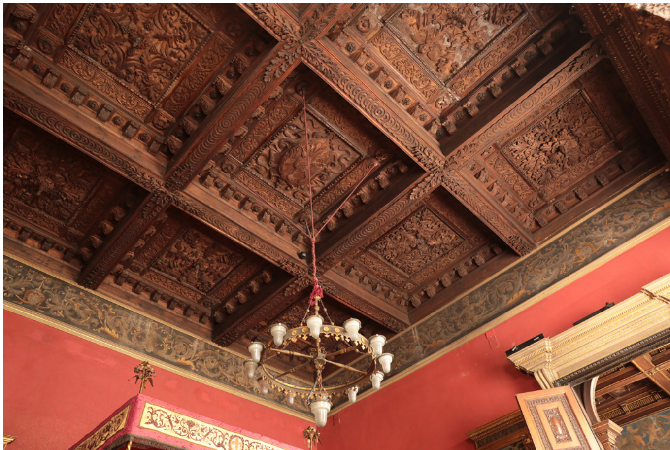
FIG. 1. Casa Bagatti Valsecchi, via Gesù 5, Milano. Vista del solaio ligneo a cassettoni della Camera Rossa, acquistato a Cremona e riadattato nel palazzo milanese negli anni Ottanta del XIX secolo. Fotografia scattata dagli autori.
