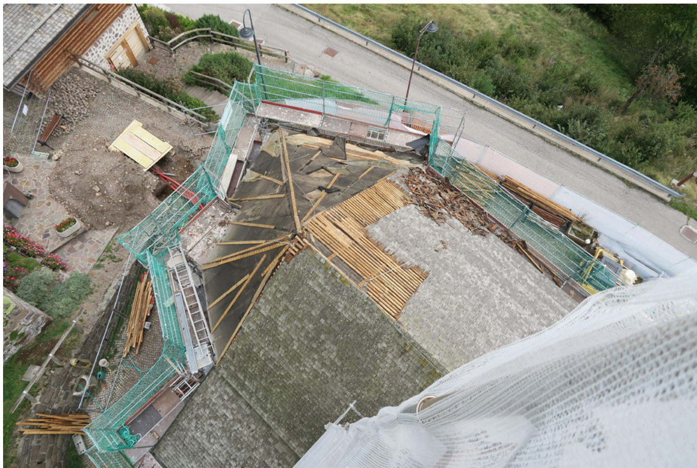
Fig. 3: Palù del Fersina. Vista dal campanile della copertura durante i lavori di rifacimento, Giorgia Gentilini.
