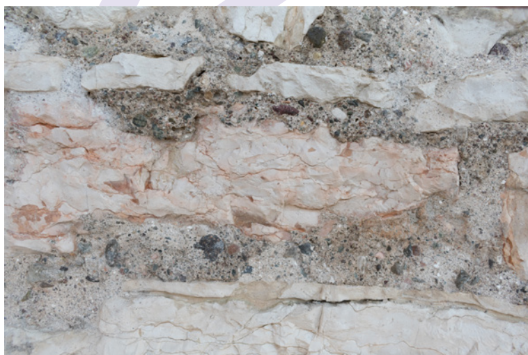
Fig. 5: Trento, Mura di Piazza Fiera, dettaglio del paramento restaurato con malta antica e di restauro, M. Mazzocchi.
