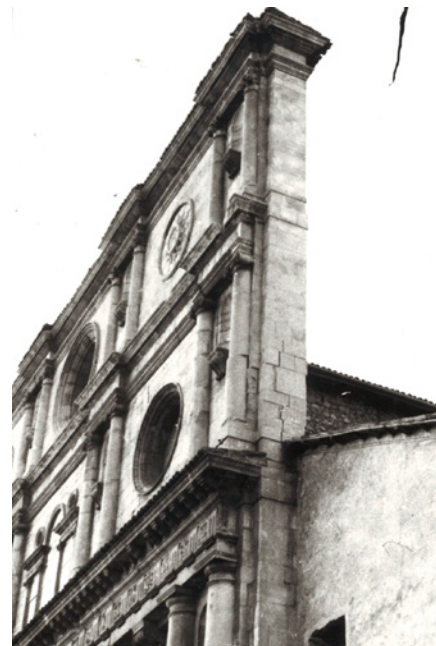
Figg. 3-4. A sinistra, proposta di intervento per il consolidamento della facciata di San Bernardino dell'arch. Biolchi, Sabap AQ TE - ASM, vedi nota 14; a destra, immagine della facciata di San Bernardino che conserva ancora i danneggiamenti descritti nella relazione del 1922, ovvero lo spostamento del rocchio di colonna e le fessurazioni sullo spessore, all'alba del 1959, Sabap Archivio Fotografico, cassetto 35, L'Aquila, Chiesa di S. Bernardino – Facciata laterale – n. neg. 7046). Su Concessione del MiC - Soprintendenza ABAP per le province di L'Aquila e Teramo.
